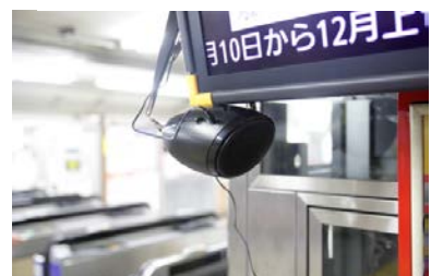
駅構内に設置した スピーカー設備から一斉放送
